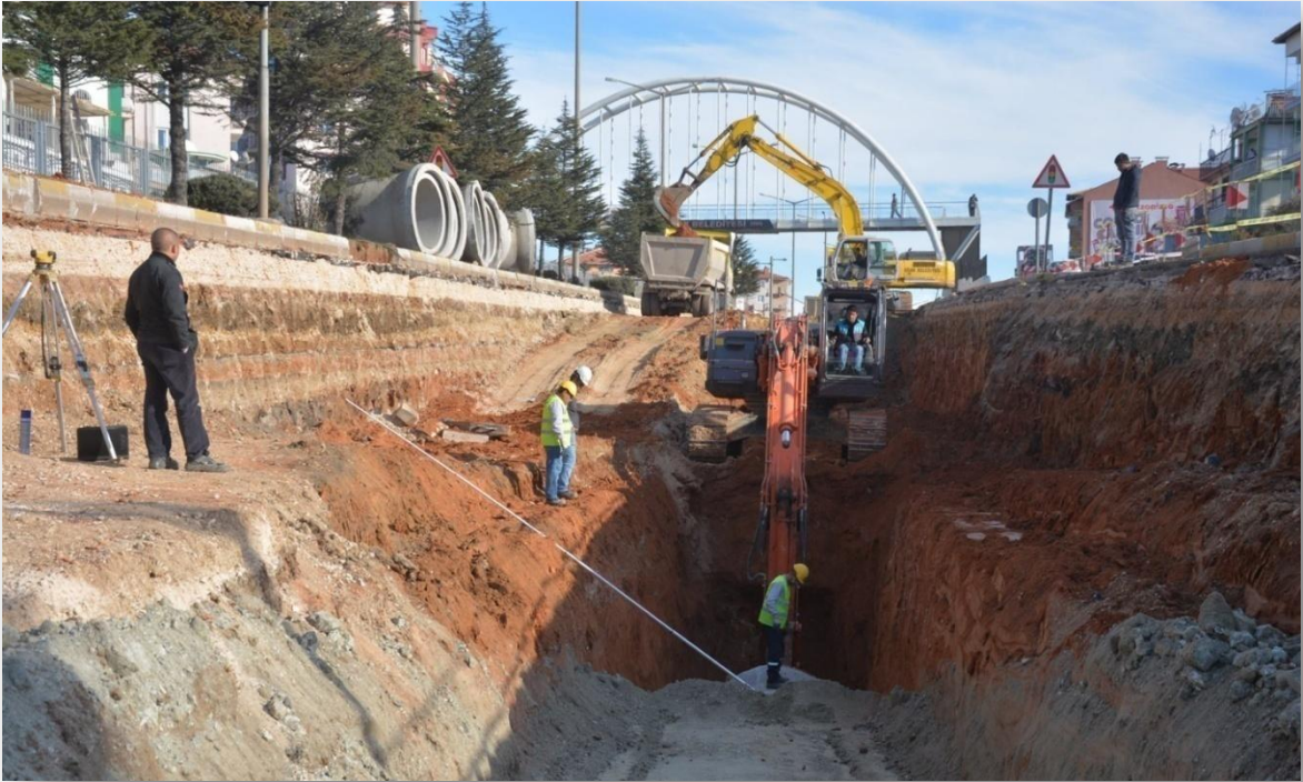
KASAPOĞLU DERESİ İLE MEDICAL PARK HASTANESİ ARASI ø 1400'LÜK BETONARME YAĞMUR SUYU HATTI
