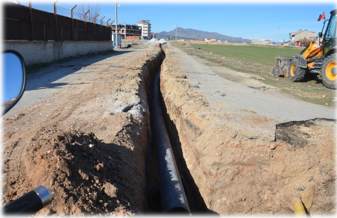
F.ÇAKMAK MH.6.KILIÇ SK. İÇME SUYU HATTI DÖŞEMESİ
