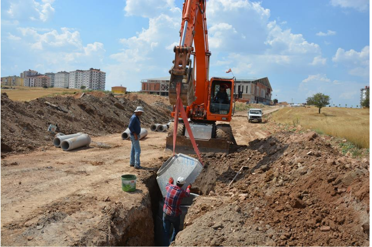
ANAFARTALAR CD.(YENİ KAPALI SPOR SALONU) KANALİZASYON HAT DÖŞEME
