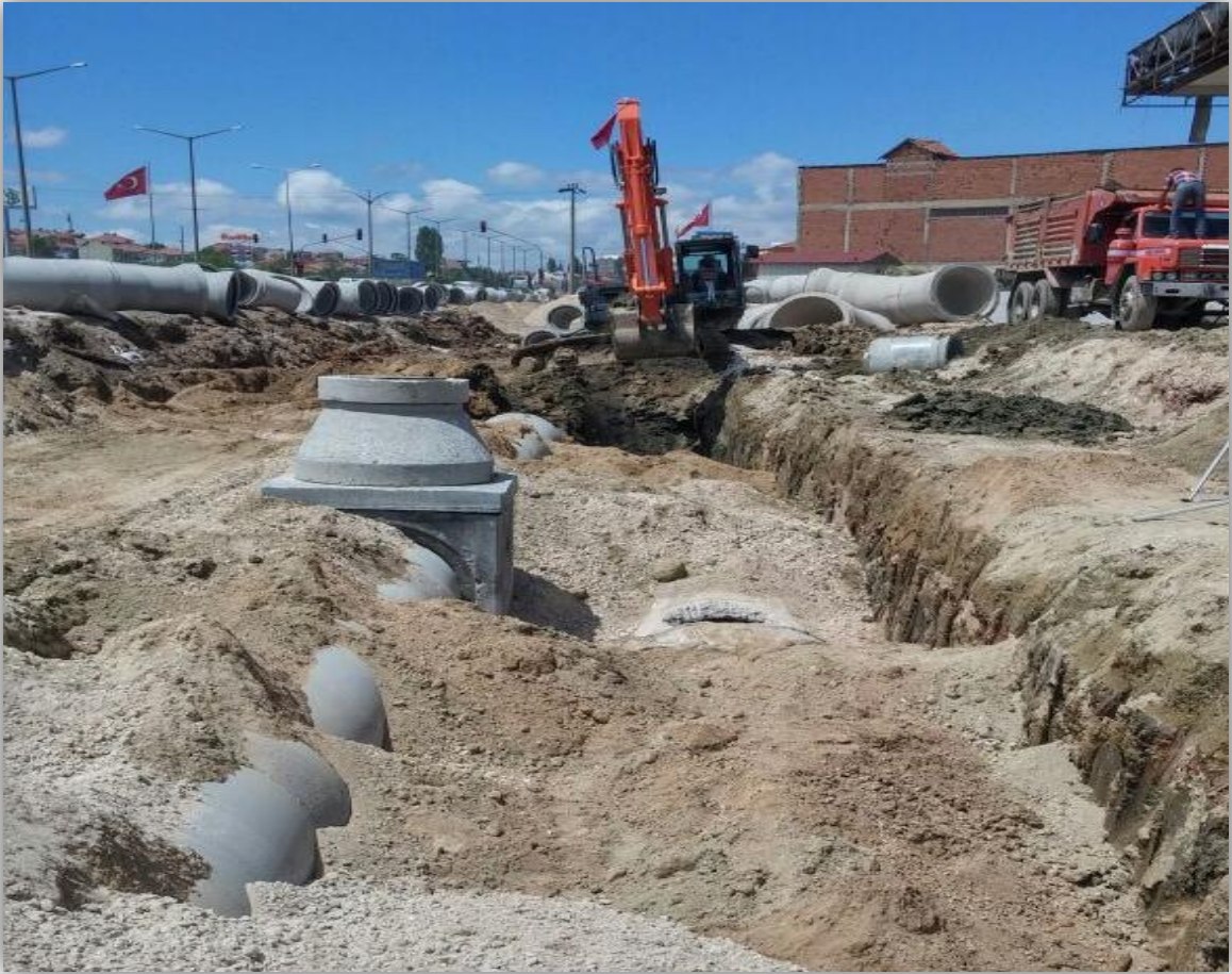
ÖZDİLEK KAVŞAĞI KANALİZASYON VE YAĞMUR SUYU HAT DÖŞEME
