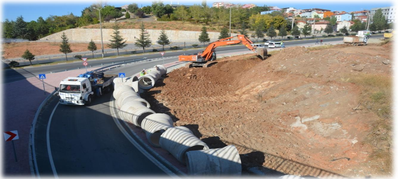
KASAPOĞLU DERESİ İLE MEDICAL PARK HASTANESİ ARASI ø 1400'LÜK BETONARME YAĞMUR SUYU HATTI
