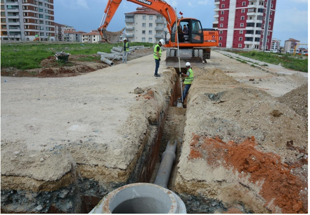
KEMALÖZ MH.1.YÖRE SK.KANALİZASYON HAT DÖŞEME
