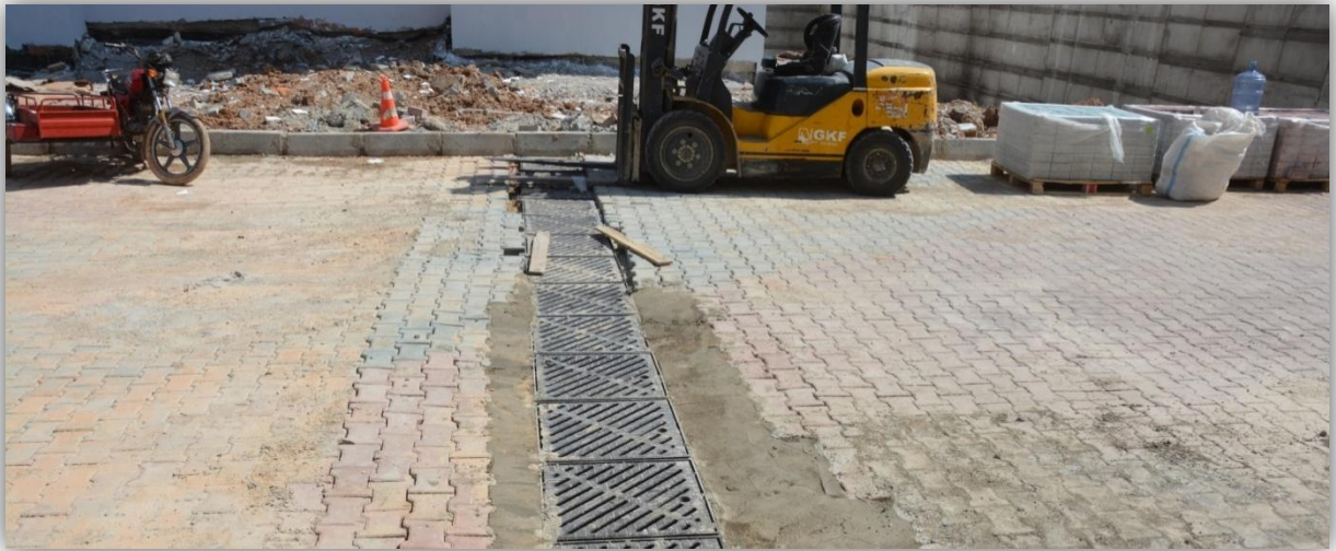
DİKİLİTAŞ MH. TOLGA VE KORAY SOKAKLAR KANELET YAPIMI
