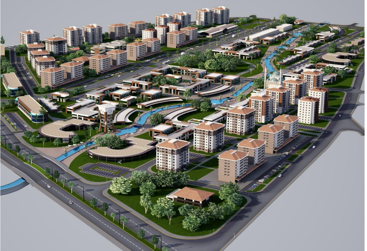
Kentsel Dönüşüm Alanı Görüntüsü
