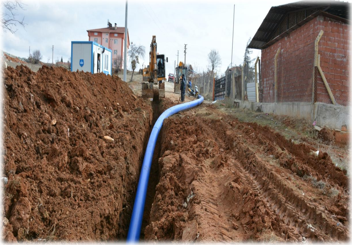
HACIKADEM 1000 M 3 'LÜK DEPODAN HACIKADEM CD.ARASI ø 315'LİK İÇME SUYU HATTI YENİLEME
