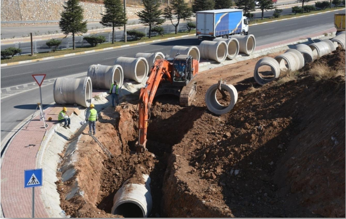
KASAPOĞLU DERESİ İLE MEDICAL PARK HASTANESİ ARASI ø 1400'LÜK BETONARME YAĞMUR SUYU HATTI
